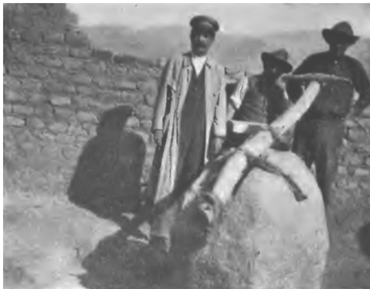
El maray —con el moedor al frente— moviendo esta mole de granito, del “asta” sobre un plano de piedra, se pulveriza el mineral para beneficiarse.
